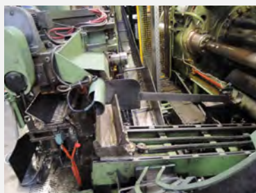
Bild 7: Beengte Platzverhältnisse bei bestehenden Anlagen
